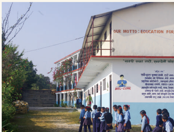
改修工事が完成した校舎と子ども達
