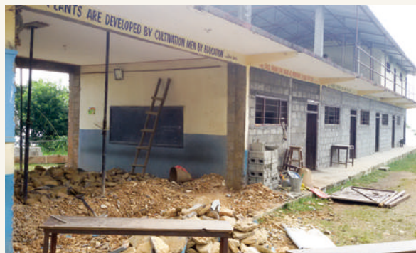
大地震で被災した校舎の復旧
